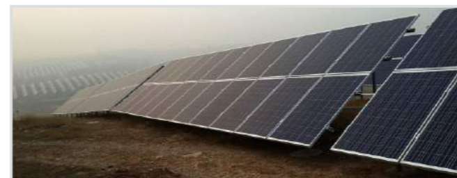
项目地 Project sites: Henan 容量 Volume: 50MW 时间 Time: 2016.4
